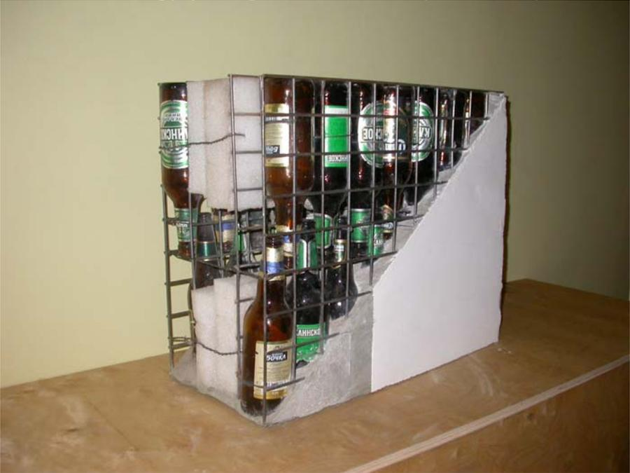
Технологию, которую мы предлагаем можно применять только при изготовлении строительных блоков, но и при возведении заборов, перегородочных стен и хозяйственных построек, а также для заполнения межстоечного пространства. Фрагмент такой стены состоит из двух сеток, между которыми горлышком к гор-
